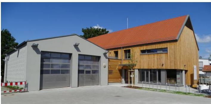
Im neuen Bürger- und Feuerwehrhaus in Kriegenbrunn stehen Vereinen und Gruppen nun ein Gruppenraum mit rund 44 m 2 und ein großer Mehrzweckraum mit rund 110 m 2 zur Verfügung.
